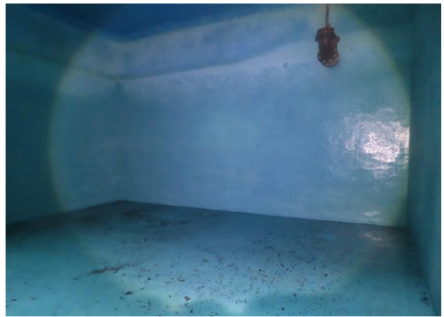
배수지 내부 전경
