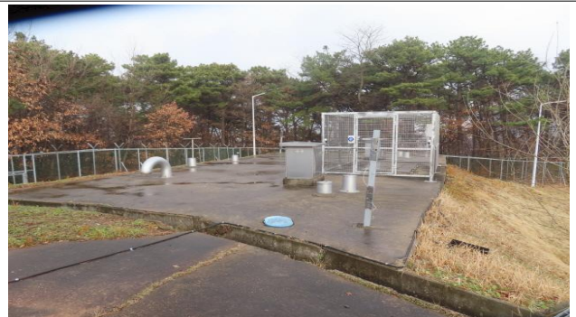
금회 정밀안전점검 전경
