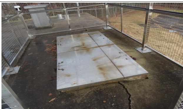
배수지 1지, 2지 덮개 상태양호
