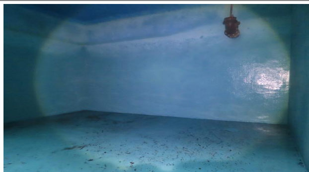
배수지 1지 내부 전경
