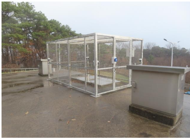
배수지 외부 전경
