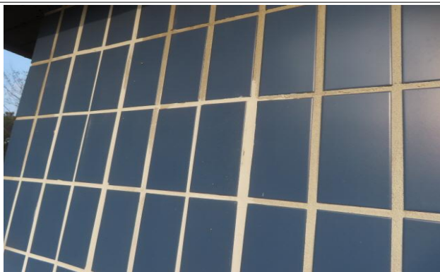
전기실 외부 벽체 타일파손 보수완료
