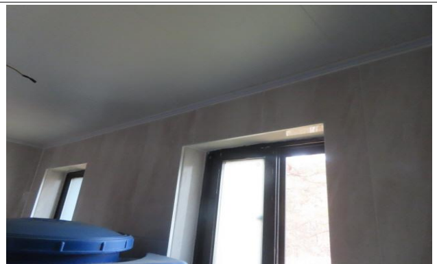
전기실 내부 벽체 타일파손 보수완료
